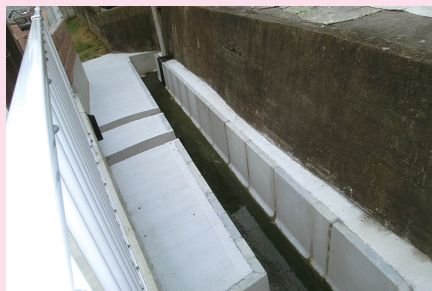
▲柴垣2丁目／水路改修
