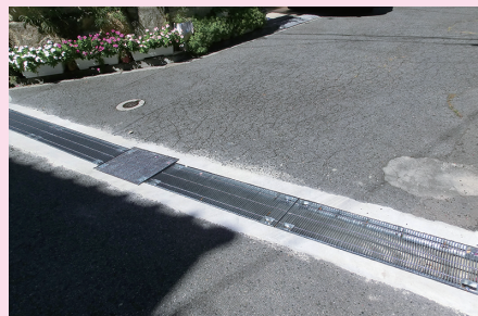
▲岡4丁目／側溝改修
