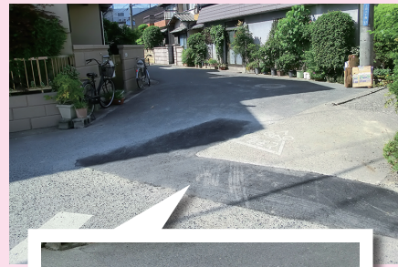
▶上田8丁目／道路補修
