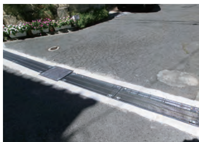
▲岡4丁目 側溝改修
