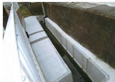
▲柴垣2丁目 水路改修
