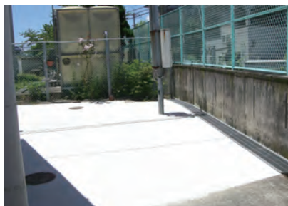
▲松原中央公民館 駐輪場舗装改修
