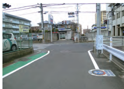
▲上田1丁目 通学路グリーンベルト整備
