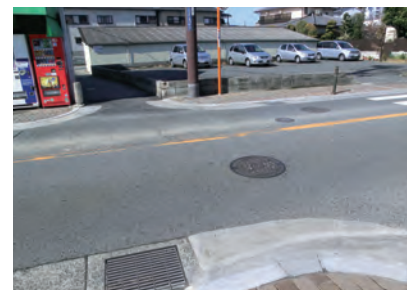
▲上田3・5丁目から8丁目までの歩道 ▼の段差改修 (堺・大和高田線「上田東」交差点より南へ)
