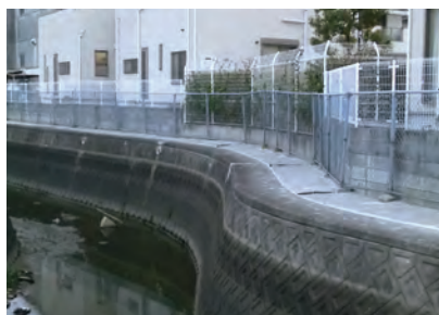
▲岡1丁目 河川土手改修
