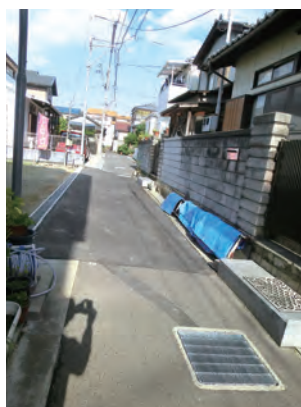
▲新堂3丁目 グレーチング設置
