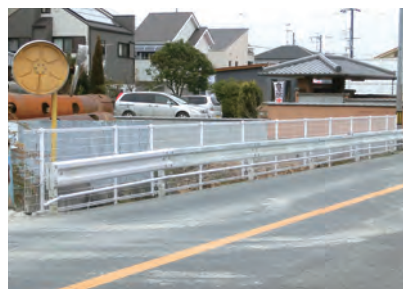
▲丹南 通学路防護柵の設置
