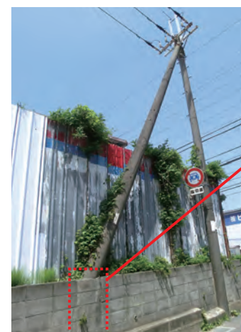
▲西野々1丁目踏切手前(電柱基礎部分補強)
