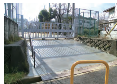
▲松原東小学校(避難所)裏門の傾斜改修
