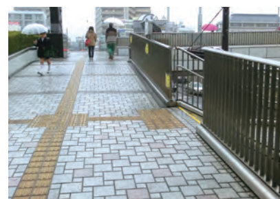
▲河内松原駅歩道橋傾斜床面改修(滑り止め塗装)、転倒予防表示
