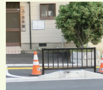
▲道路安全柵の設置 (立部3丁目〈上ノ池会館前〉)
