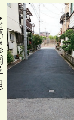
▶側溝転落防止ポールの設置 (岡4丁目)
