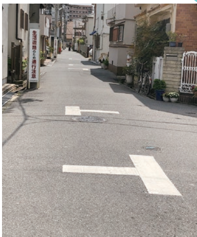
田井城地域の路面標示（7カ所）
