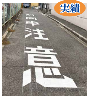
▲田井城2丁目 道路標示改修
