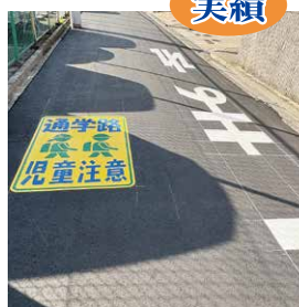
▲東新町2丁目 道路表示設置
