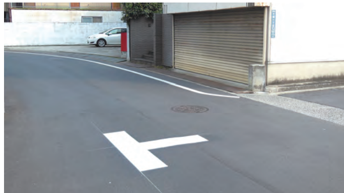
平成26年11月 大堀1-12付近に、安全確保のため、交差点マークの道路標示をさせて頂きました。
