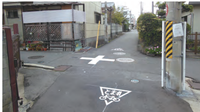
平成26年11月 一津屋5-5-28付近、安全確保のため、とまれ・交差点道路標示をさせて頂きました。
