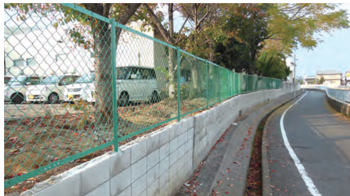
平成26年11月 大堀1-5付近、住江織物裏、東除川に面したブロック塀を防御柵にさせて頂き、歩行者の安全確保に努めました。
