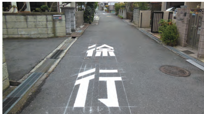
平成26年11月 一津屋5-7-7付近、安全確保のため、徐行道路標示をさせて頂きました。
