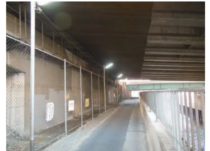
平成27年1月 大堀2-21-32付近、新大堀橋の防犯灯のカバーの清掃及び、電球の交換をさせていただきました。
