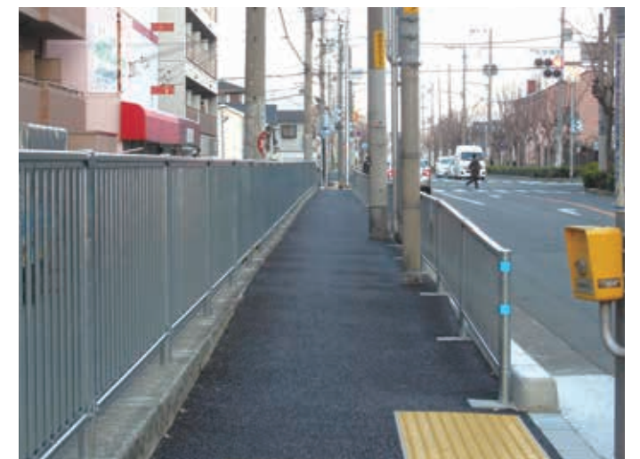
平成27年1月 府道大堀堺線、天美東6-11-2～7富田被服前付近の歩道の整備及び、防御柵の整備をさせていただきました。
