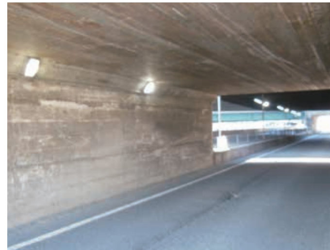
平成27年1月 大堀1-14-30付近、新大堀橋の防犯灯のカバーの清掃及び、電球の交換をさせていただきました。
