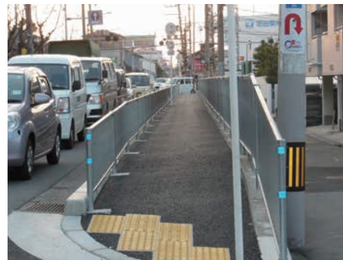
平成27年1月 府道大堀堺線、阿部産婦人科前の歩道の整備及び、防御柵の整備をさせていただきました。
