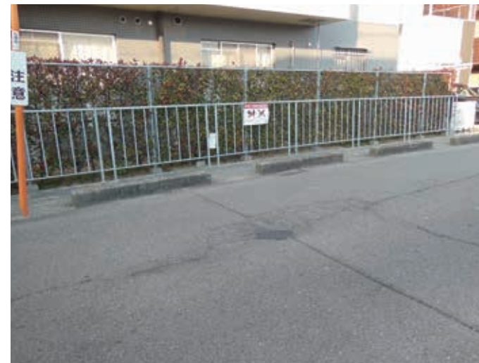
平成27年1月 天美南2-192ベルドミール天美前の陥没を修理させていただきました。
