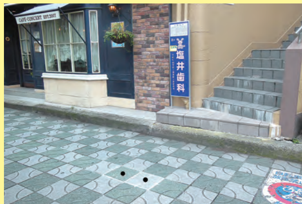
平成27年6月 天美駅周辺、塩井歯科前の歩道ブロックのガタツキを修正させて頂きました。
