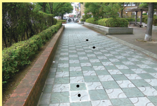
平成27年6月 天美駅より阪南大学方向、朝日プラザマンションの横の歩道ブロックのガタツキを修正させて頂きました。
