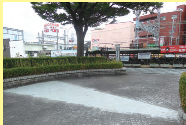
平成27年6月 天美駅前の歩道の段差とガタツキ、ヒビワレを解消するために、修理をさせて頂きました。
