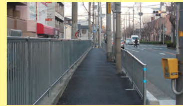
平成27年1月 天美東6-11-2~7、歩道の整備及び、防御柵の整備
