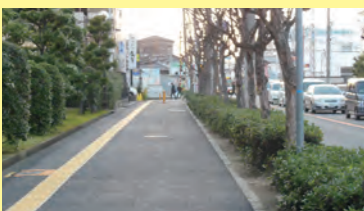
平成27年1月 天美東7-12-25付近、歩道の整備
