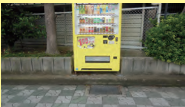
平成27年5月 朝日プラザマンション横、グレーチングの段差を解消
