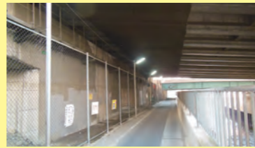
平成27年1月 大堀2-21-32付近、防犯灯のカバーの清掃及び、電球の交換
