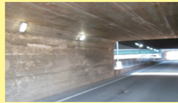
平成27年1月 大堀1-14-30付近、防犯灯のカバーの清掃及び、電球の交換
