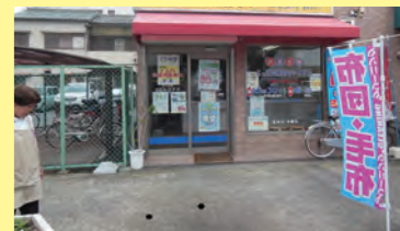
平成27年7月 フタバクリーニング前、水がたまらないように補修
