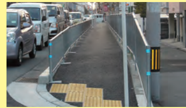
平成27年1月 阿部産婦人科前の歩道の整備及び、防御柵の整備
