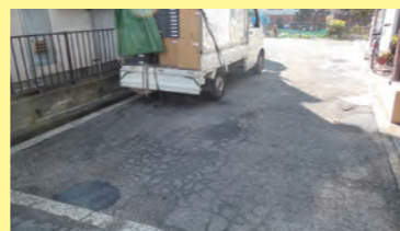
平成27年2月 小川5-14-11付近、道路陥没の修理
