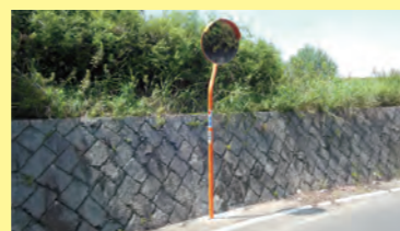
平成27年8月 大堀5丁目、新しいカーブミラーを設置
