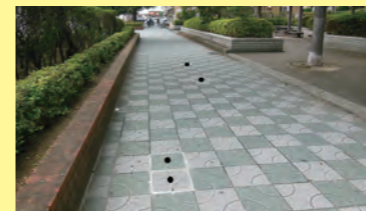
平成27年6月 朝日プラザマンション横、歩道ブロックのガタツキ修正
