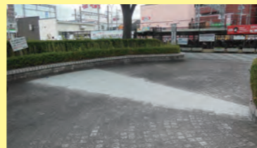
平成27年6月 天美駅前の歩道の段差とガタツキ、ヒビワレ修理
