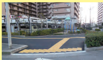
平成27年1月 ルネグランスステージ前の歩道の整備
