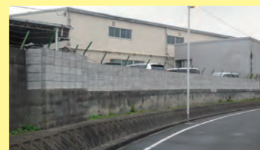
平成27年5月 大堀1-7付近、ブロック塀を新しく設置
