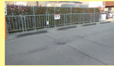
平成27年1月 天美南2-192、道路陥没を修理
