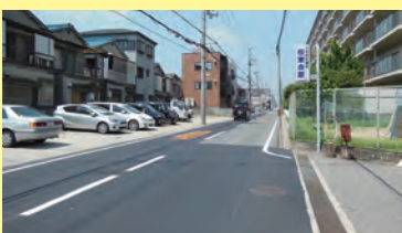
平成27年7月 三宅西4-534-5、道路舗装工事
