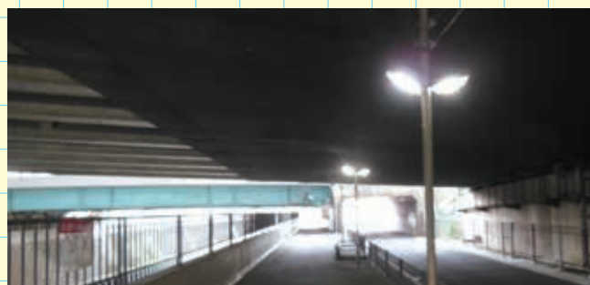
平成28.1月 大堀1-14-30付近 新大堀橋高架下の歩道側の防犯灯をLEDに交換
