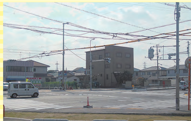
平成28年3月 三宅新道交差点の歩道橋を撤去し、横断歩道の整備をさせていただきました。
