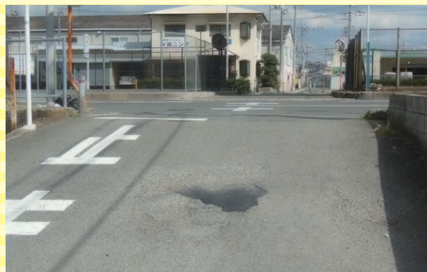
平成28年2月 三宅西5-785付近、安全確保のため、道路陥没を修理させていただきました。
