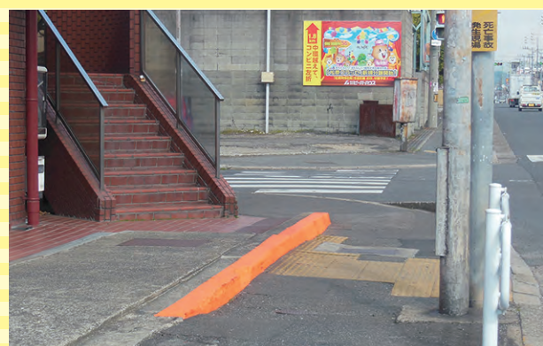
平成28年3月 阿保5丁目交差点手前の歩道で自転車が段差に気づかずけがをされたので、応急処置として朱赤蛍光塗料を塗らせていただきました。
