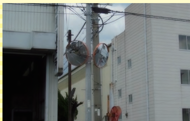
平成28年3月 三宅西4-542-1 (株)汐見製作所前に、安全確保のためカーブミラーを設置させていただきました。
