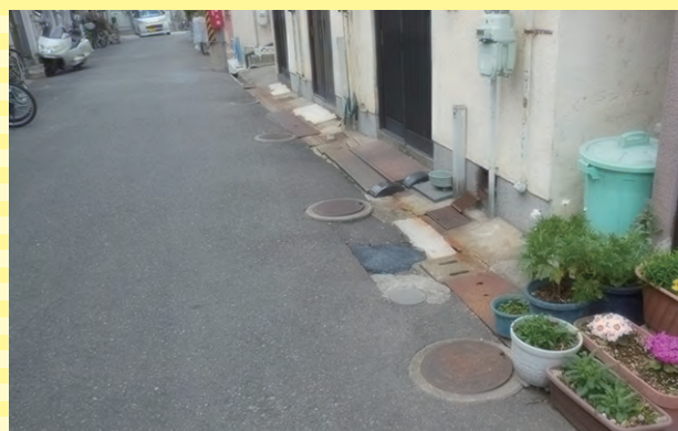
平成28年2月 天美南2-117-22付近、安全確保のため、道路陥没を修正させていただきました。
