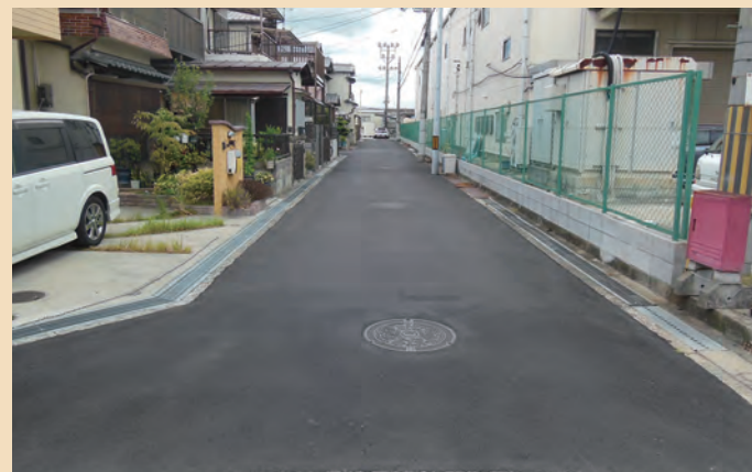
平成28年6月 三宅東1-9-33～38の区間 凸凹のため道路舗装をさせていただきました。
