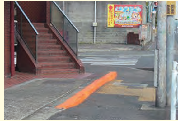
平成28年3月 阿保5丁目交差点手前の歩道で自転車が段差に気づけずけがをされたので、応急処置として朱赤蛍光塗料を塗らせていただきました。
