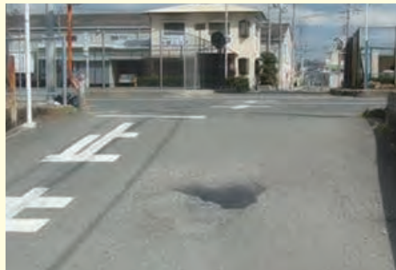
平成28年2月 三宅西5-785付近、安全確保のため、道路陥没を修理させていただきました。
