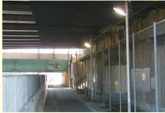
平成28年1月 大堀2丁目21-12付近 新大堀橋高架下の防犯灯をLEDに交換をさせていただきました。
