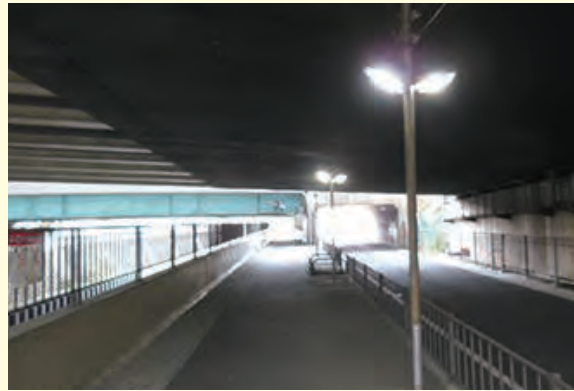
平成28年1月 大堀1-14-30付近 新大堀橋高架下の歩道側の防犯灯をLEDに交換をさせていただきました。
