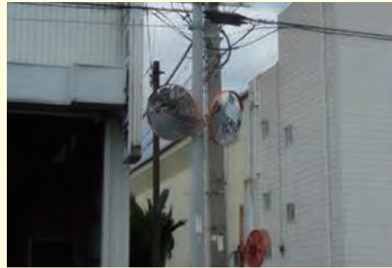
平成28年3月 三宅西4-542-1 (株)汐見製作所前に、安全確保のためカーブミラーを設置させていただきました。
