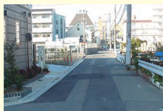
平成28年10月 天美東4-308付近 凸凹のため道路舗装をさせていただきました。
