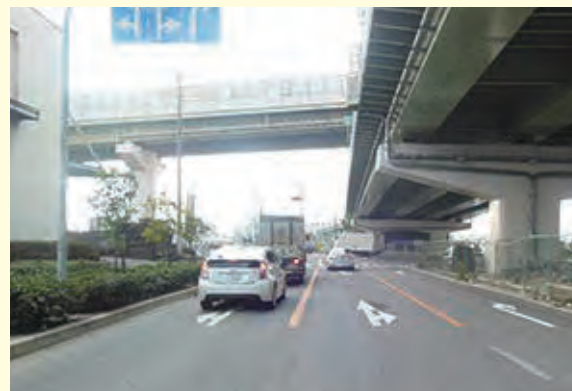
平成28年3月 三宅ランプ北手前、住吉八尾179号線が天美西方面まで開通するにあたり交通量の増加のため、2車線右折から直線右折へと変更させていただきました。
