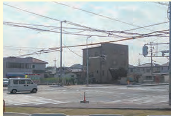
平成28年3月 三宅新道交差点の歩道橋を撤去し、横断歩道の整備をさせていただきました。
