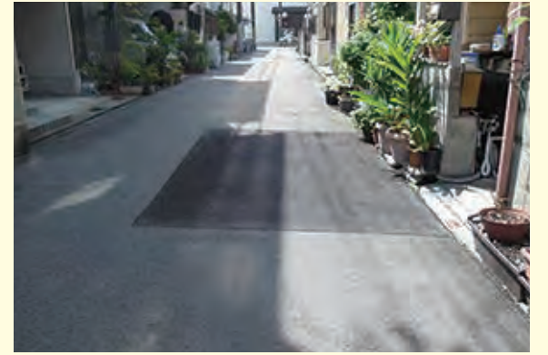
平成28年6月 天美東5-3-7付近 凸凹のため道路舗装をさせていただきました。
