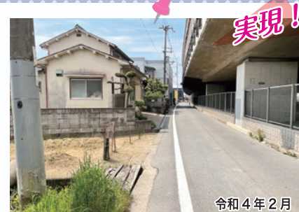
小川3-9-7付近から小川3-8-13付近歩道の白線を、復元させていただきました。
