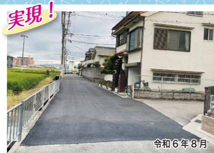
三宅中2-18-29 付近 約10年間粘り強く依頼しておりました水道事業復旧に伴う道路舗装ですが、この度、やっと完了いたしました。
