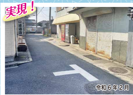
別所5-15-7 山道酒店前付近 交差点に、安全対策のため交差点マークを表示させていただきました。
