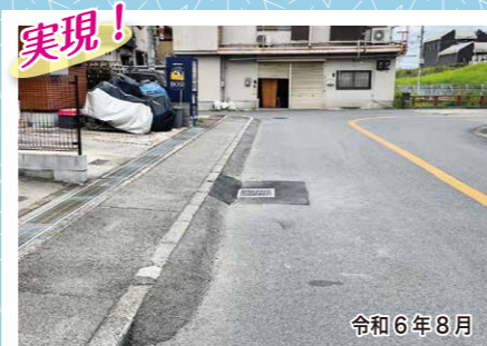
天美北5-2-28 付近 歩道横の段差解消し、バイク・自転車が安全に走行できるよう整備をさせていただきました。また、雨水対策として、グレーチングの整備もさせていただきました。
