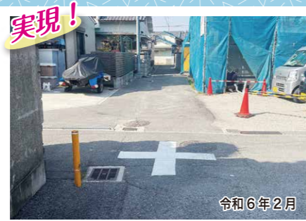
別所5-9-12 付近 交差点に、安全対策のため交差点マークを表示させていただきました。
