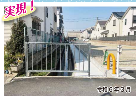
三宅西2-20-7 付近 側溝に、安全対策のため落下防護柵を付けさせていただきました！
