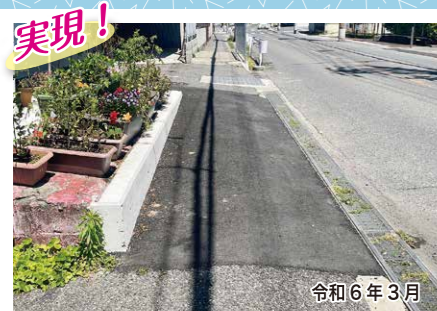
三宅中4-2-21 付近 歩道の段差を無くし、歩行者の安全確保を進めさせていただきました。
