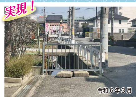
天美東5-3-3 天美ハイツ前 側溝に、安全対策のため落下防護柵を付けさせていただきました。
