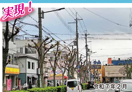
河内天美駅周辺 老朽化した水銀灯をLED照明に更新し、夜間の安全性を向上させました。
