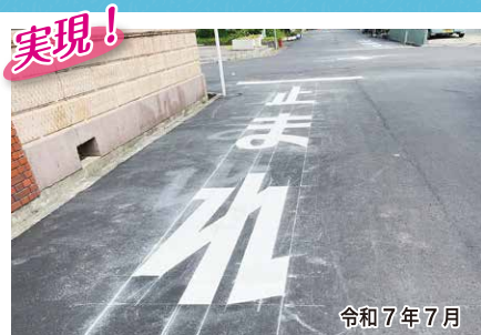
松原市天美西3丁目3-18付近 道路を整備し、「止まれ」標示を復元することで、歩行者や車両の安全性を向上させました。
