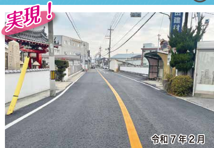
大海ゴルフ場付近の道路 大阪府の事業として実施された府道堺大堀線の道路整備に合わせ、周辺一帯の道路環境をより安全で快適なものにさせていただきました。
